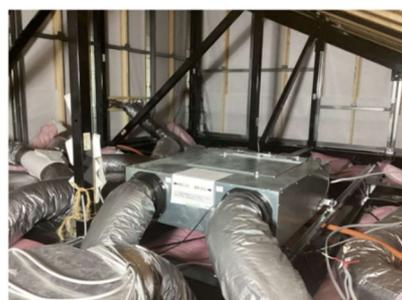
写真1 熱交換換気機器
