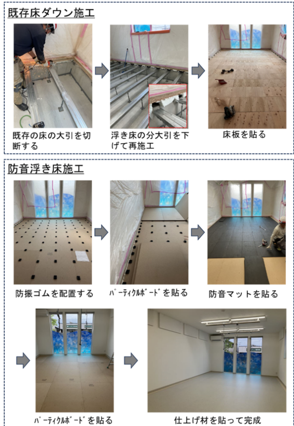
写真3 防音乾式浮き床の施工
