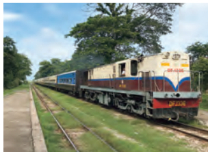
ヤンゴン・マンダレー線 線路(整備前)
