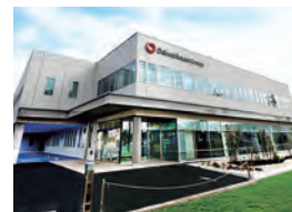
大和ハウス佐賀ビル
