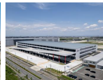
物流施設 施工：フジタ (DPL名港弥富Ⅱ)
