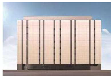
データセンター (DPDC品川港南サイト)
