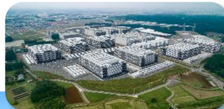
印西データセンター開発 (千葉県印西市)
