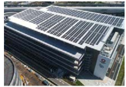
屋根に設置したオンサイトPPA
