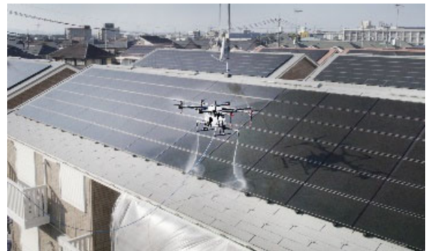
【屋根部洗浄の様子】
